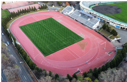
レオタンSを活用した製品の施工第一号 札幌市円山競技場(第2種公認)
